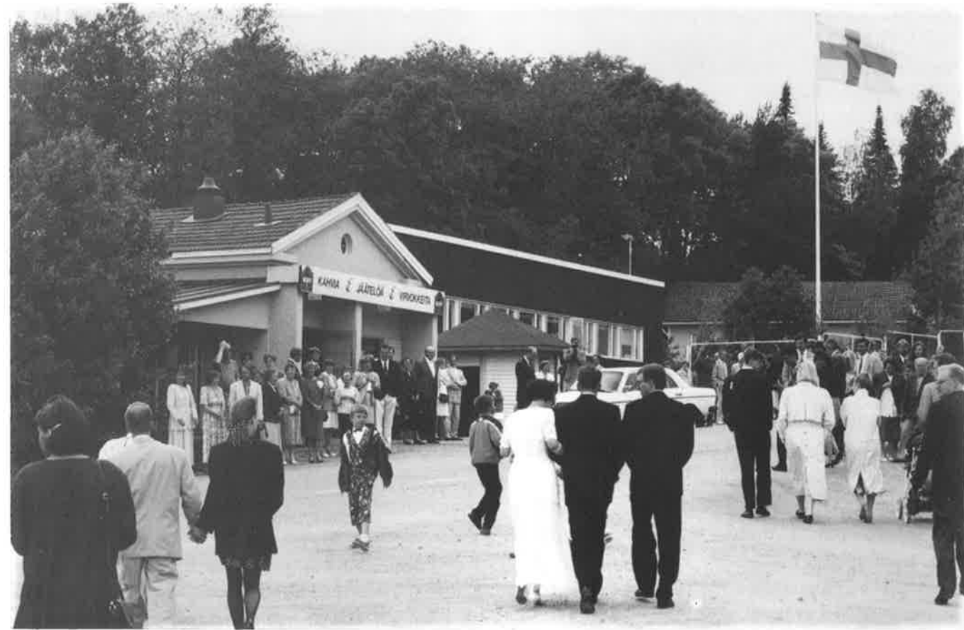
Ankkurikellarilla tanssitaan muutostöiden jälkeenkin.
